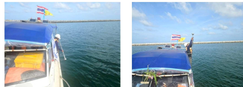
รูปที่ 5-7 ติดตั้งเสาอากาศเครื่อง GNSS และ Transducer
